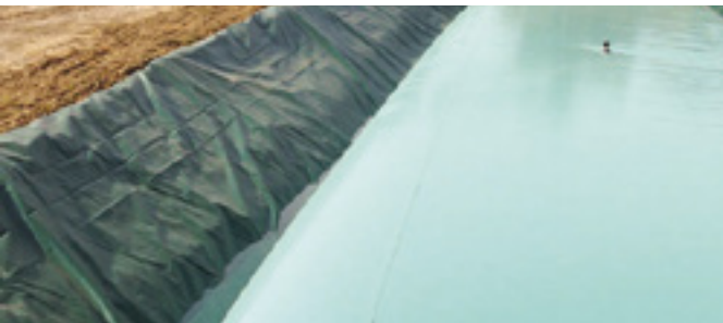
Bassin de rétention sur talus
