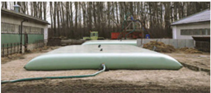
Stockage effluents 200 m 3
