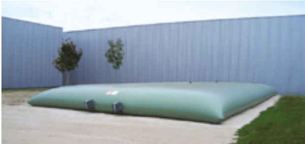
Réserve incendie - Hors Sol 240 m³
